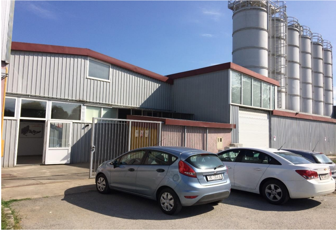
Slika 2.1. Ulaz u tvrtku „Termoline d.o.o.“
