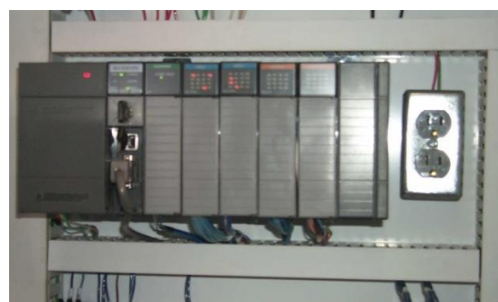
Slika 4.3. Primjer PLC-a
