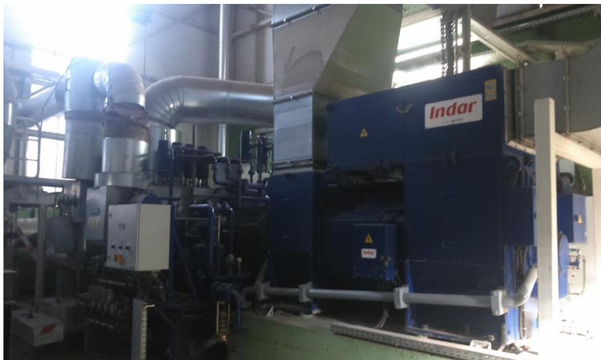
Slika 5.15. Turbo-generatorski set
