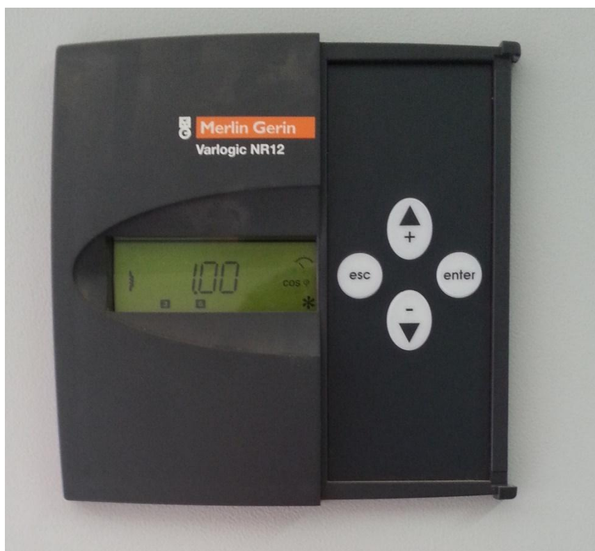
Slika 5.18. Digitalni displej prikazuje faktor snage
