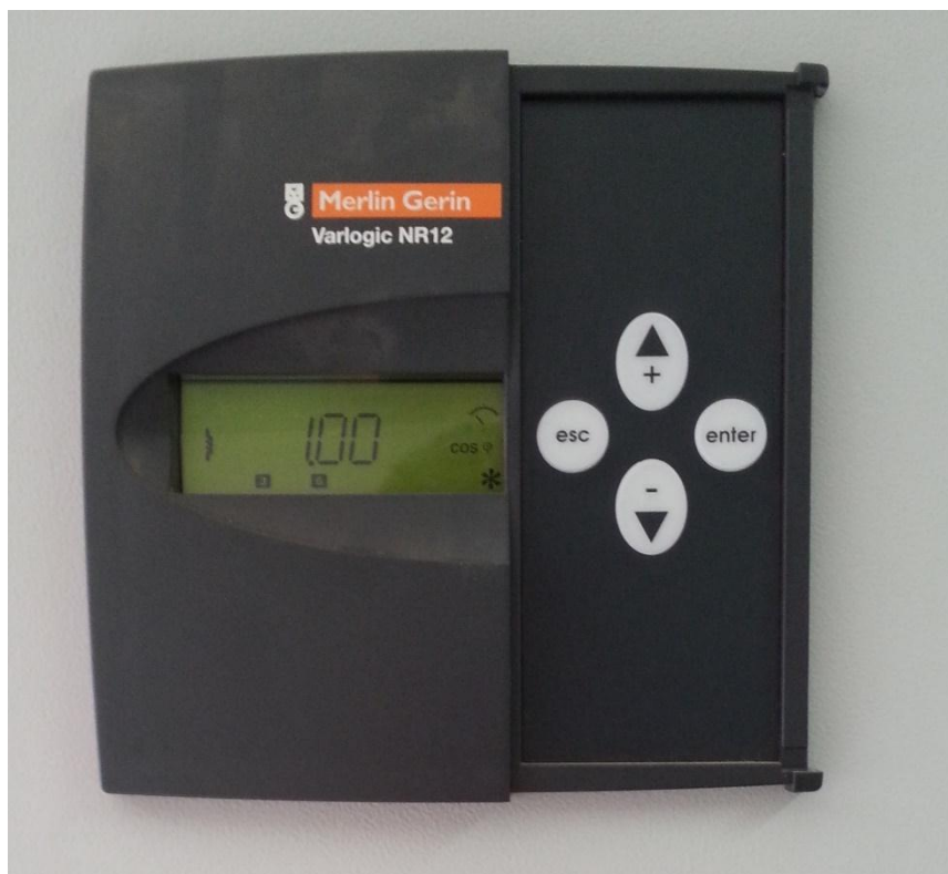
Slika 5.18. Digitalni displej prikazuje faktor snage
