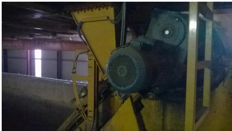
Slika 4.9. Bager „kablčar“ i asinkroni motor koji ga pokreće
