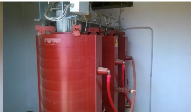
Slika 5.2. 10/0,4 kV transformator
