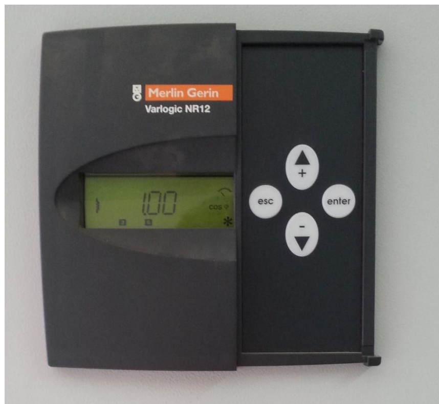
Slika 5.18. Digitalni displej prikazuje faktor snage
