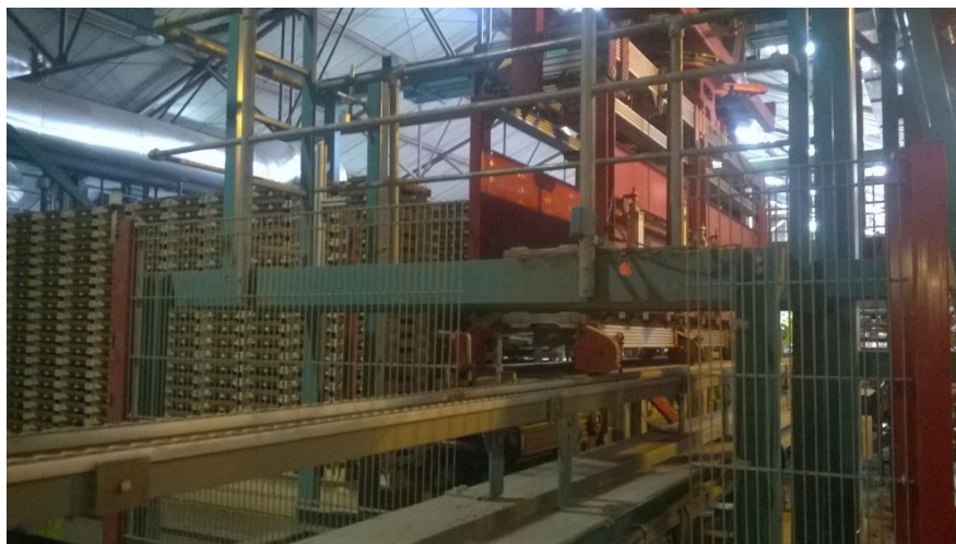
Slika 4.21. Crijep se utovara na vagonne
