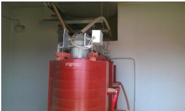
Slika 5.1. 10/0,4 kV transformator
