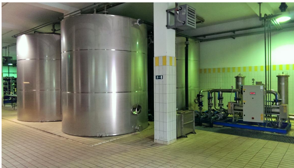
Slika 3.2. Pogon za reverznu osmozu
