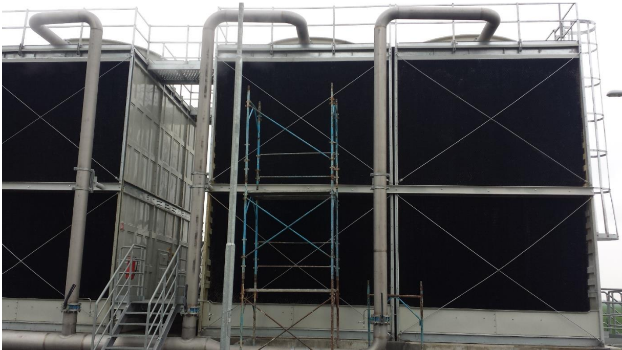
Slika 5.3. Rashladni tornjevi [5]
