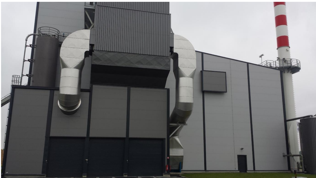
Slika 5.1. Vanjski izgled postrojenja [5]
