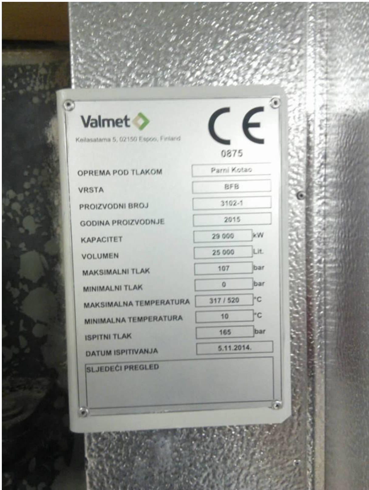
Slika 6.4. Natpisna pločica parnoga kotla [5]
