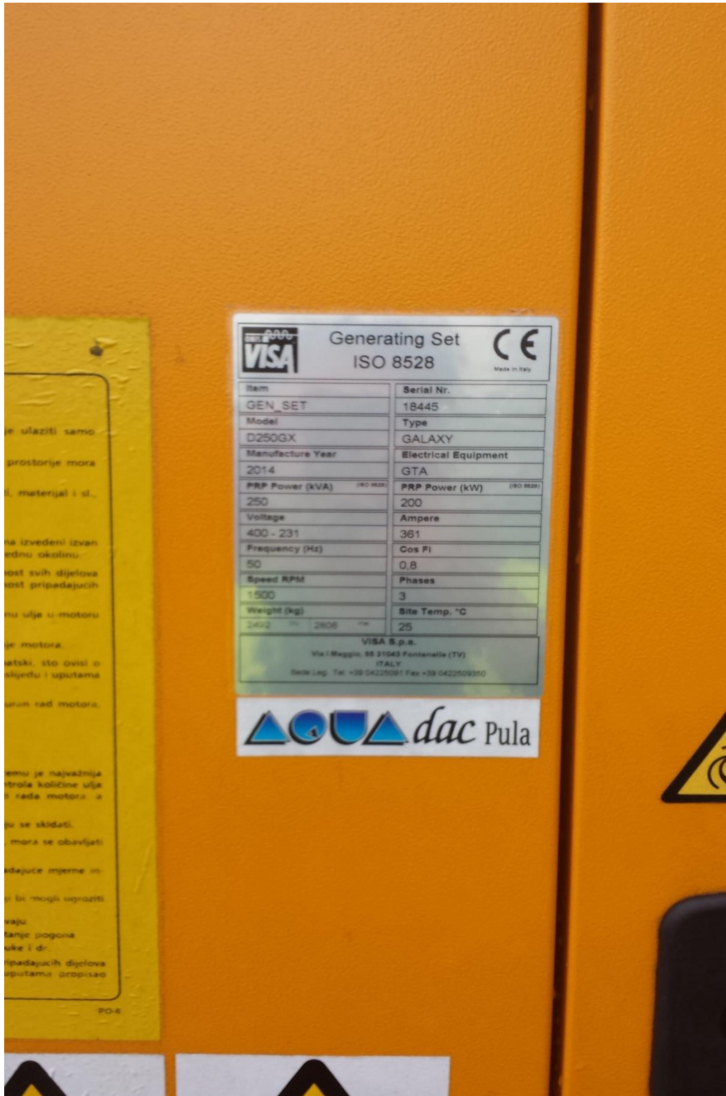
Slika 7.7. Natpisna pločica pomoćnog generatora [5]
