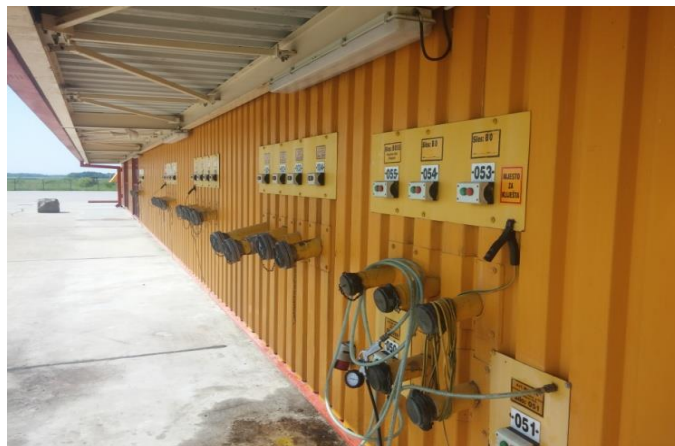
Slika 3.2. Prikaz priključaka za silose
