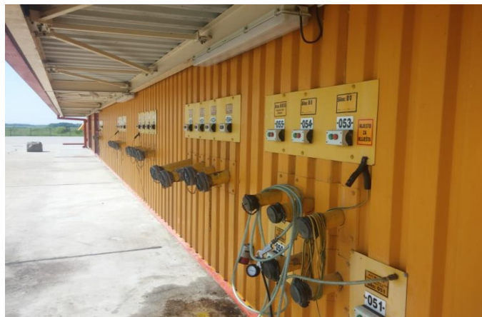
Slika 3.2. Prikaz priključaka za silose
