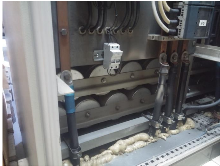
Slika 2.6. Prikaz kompezacijskih baterija
