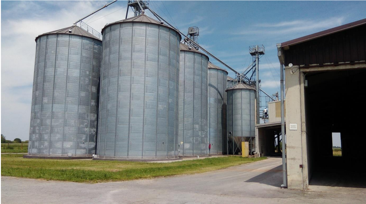
Slika 2.4. Silosi OC Šljivoševci
