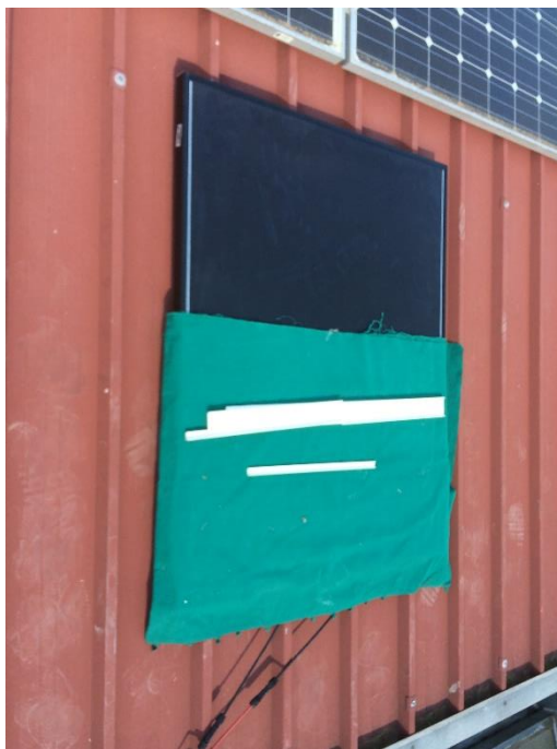
Slika 4.15. Tankoslojni fotonaponski modul pri zasjenjenju od 70 cm u trenutku obavljanja mjerenja.
