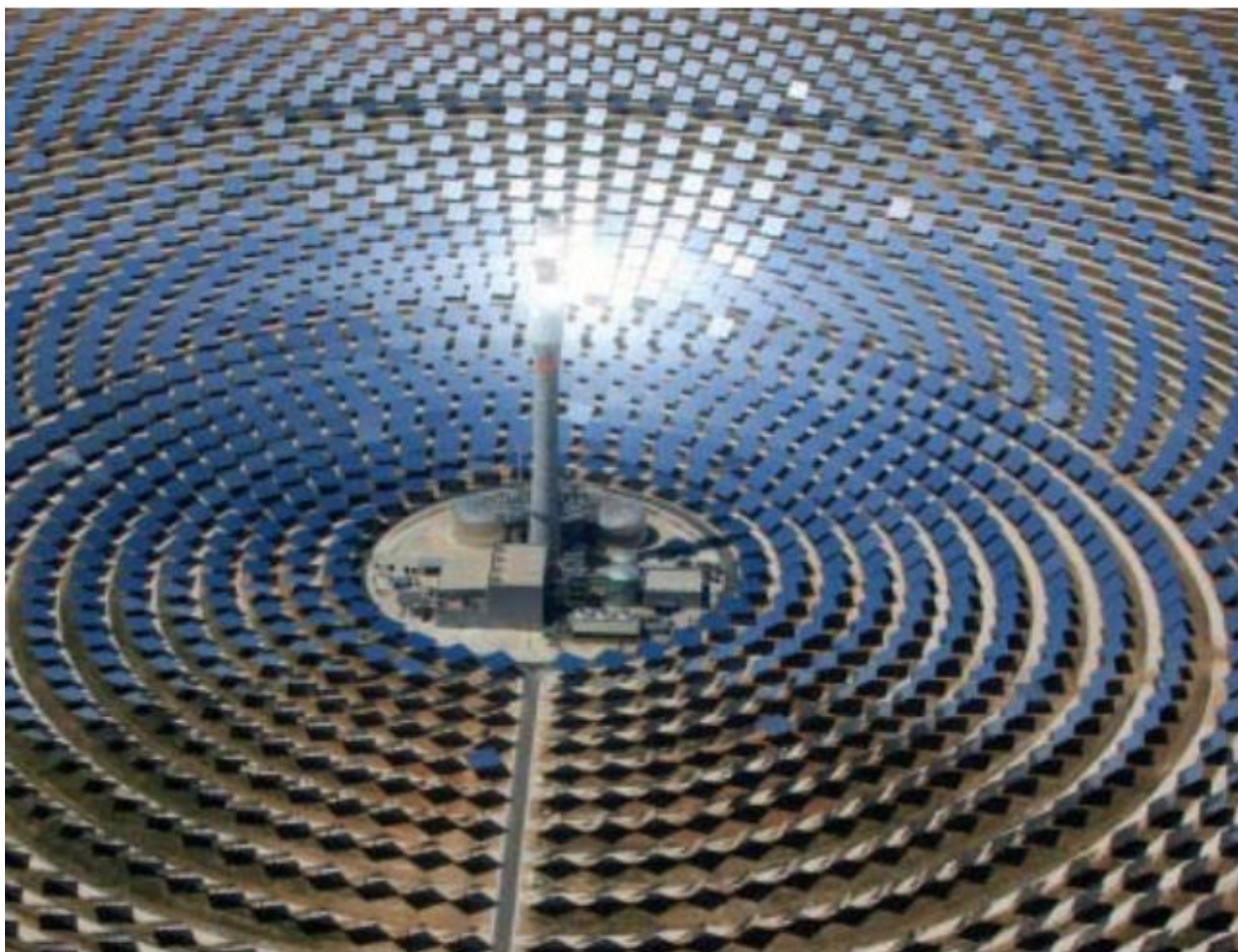
Slika 3.15 Gemasolar u Sevili, solarna termoelektrana sa skladištima rastaljene soli [1]
