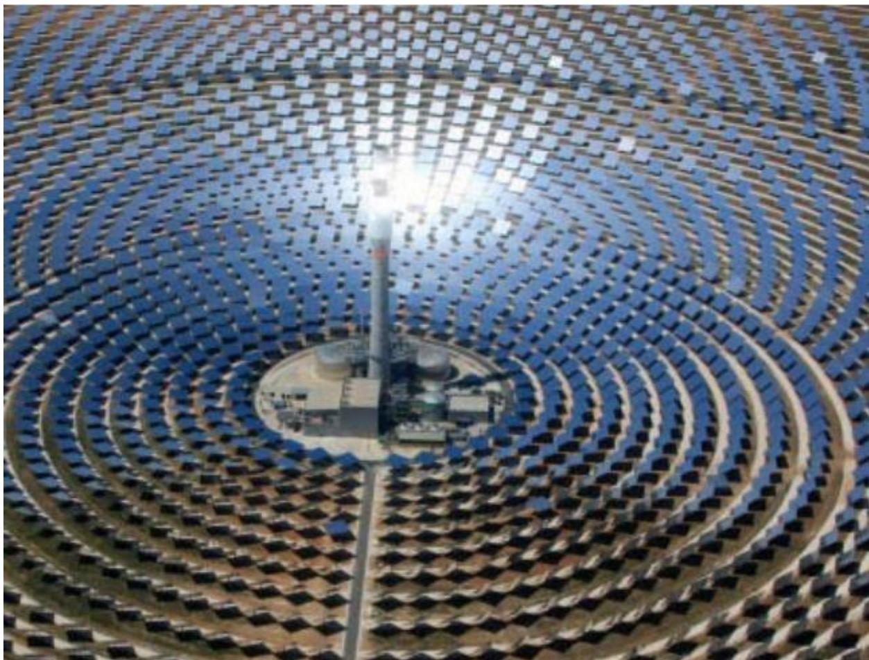
**Slika 3.15** Gemasolar u Sevili, solarna termoelektrana sa skladištim rastaljene soli [1]
