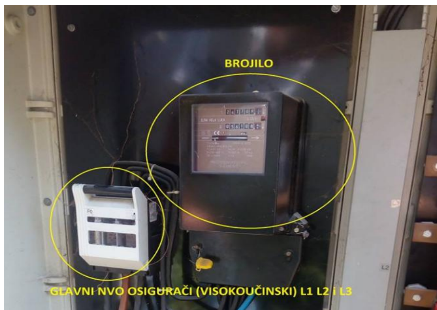
Slika 4.2.8. Sadržaj ormara javne rasvjete (OCR).
