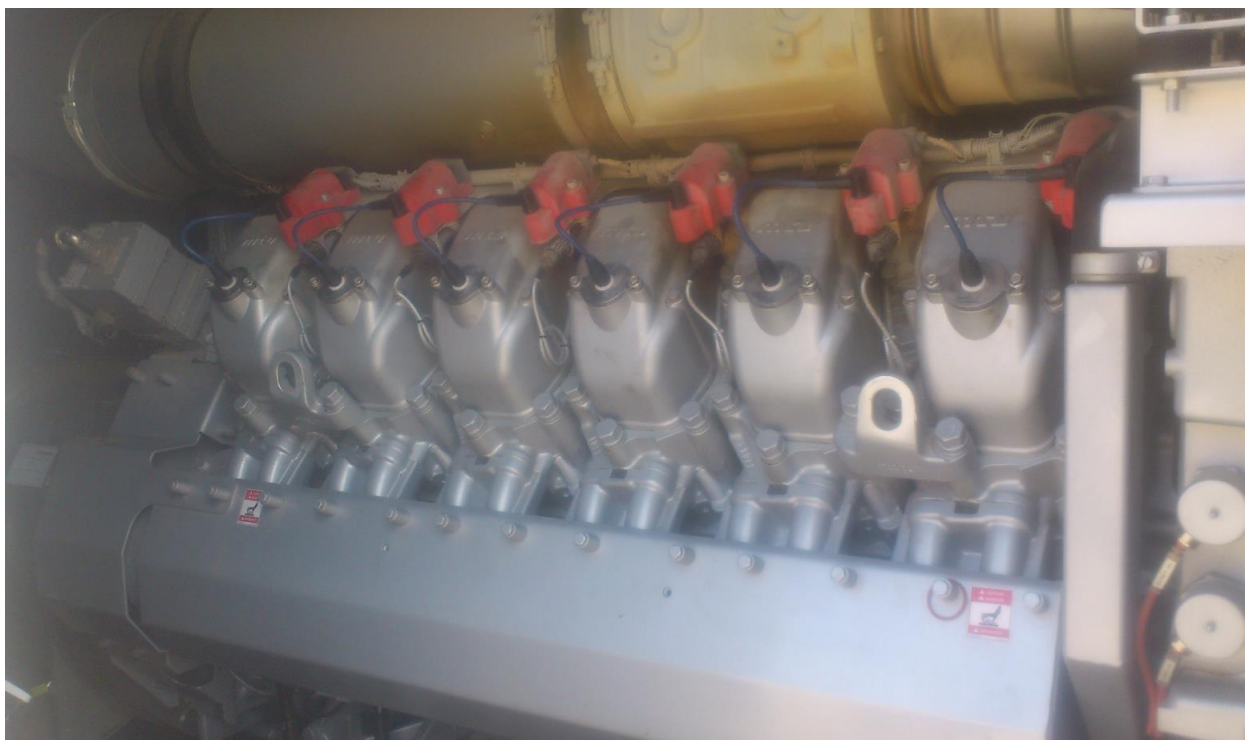
Slika 3. Plinski motor GE Jenbacher [2]
