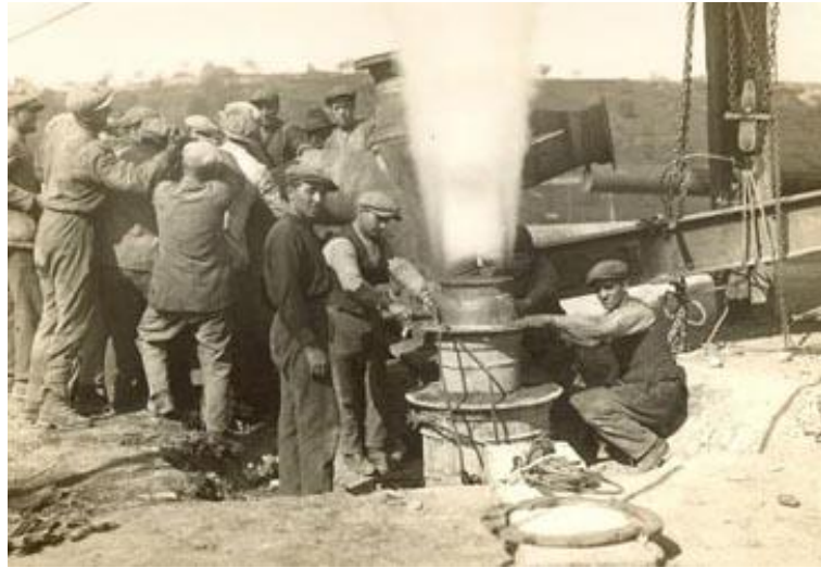
Sl. 4.2 Prva geotermalna elektrana Larderello, Italija
