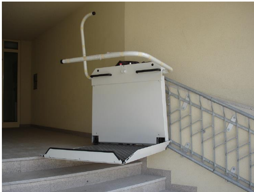
Slika 3.1. Primjer platforme dizala za osobe s invaliditetom [4].
