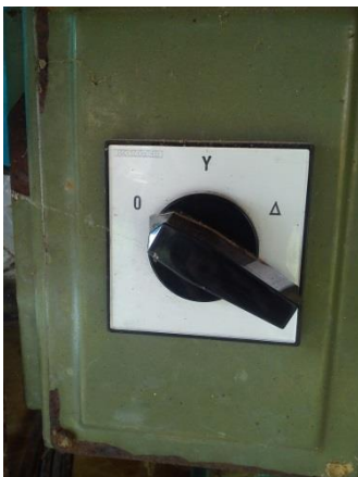
Slika 3.7. Preklopka zvijezda-trokut u pogonu
