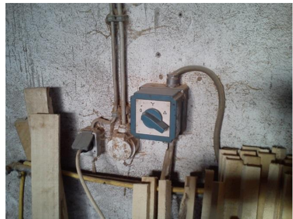
Slika 3.7. Preklopka zvijezda-trokut u pogonu
