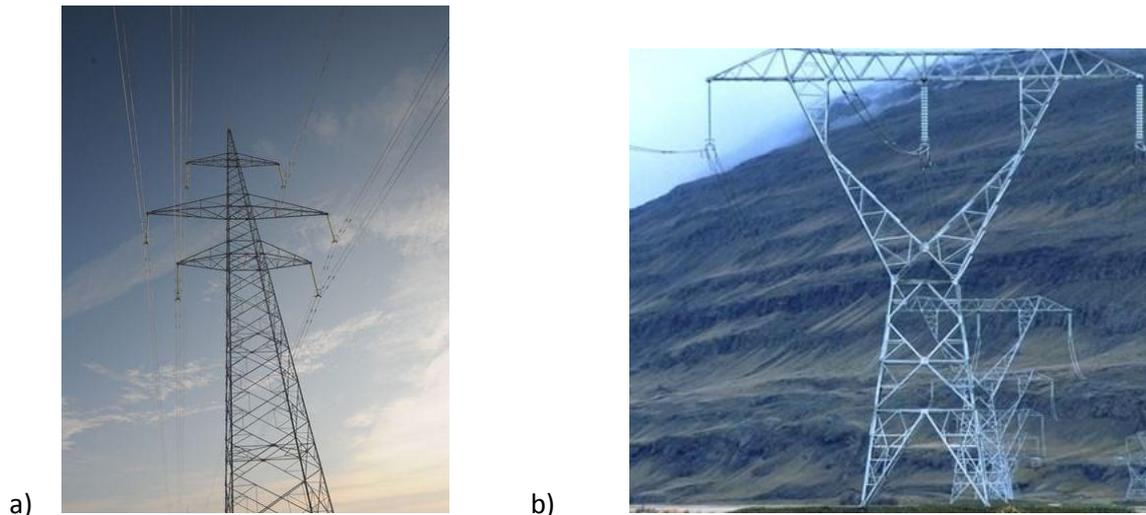
Slika 2.2. a) Dvostruki dalekovod b) Jednostruki dalekovod iz [2]
