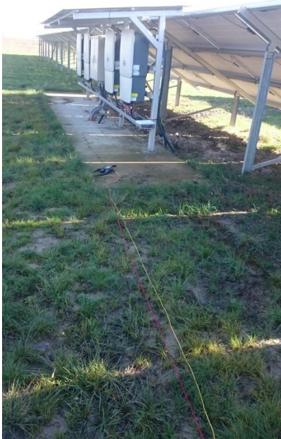
Slika 4.9. Grupa invertora 1 s mjernim uređajem i vodičima
