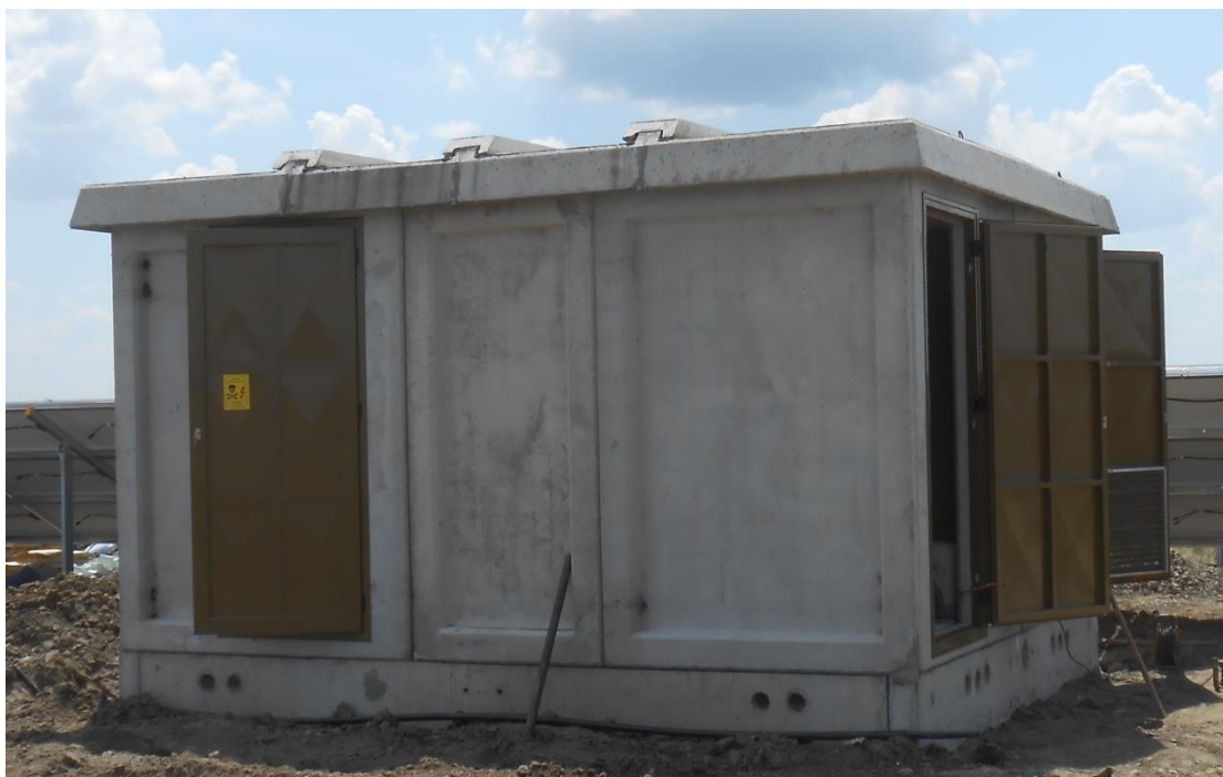
Slika 2.22. Izgled objekta CTS [14]
