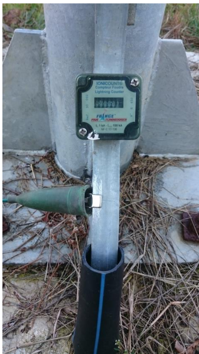
Slika 4.12. Spoj vodiča s uzemljivačem gromobrana MS2
