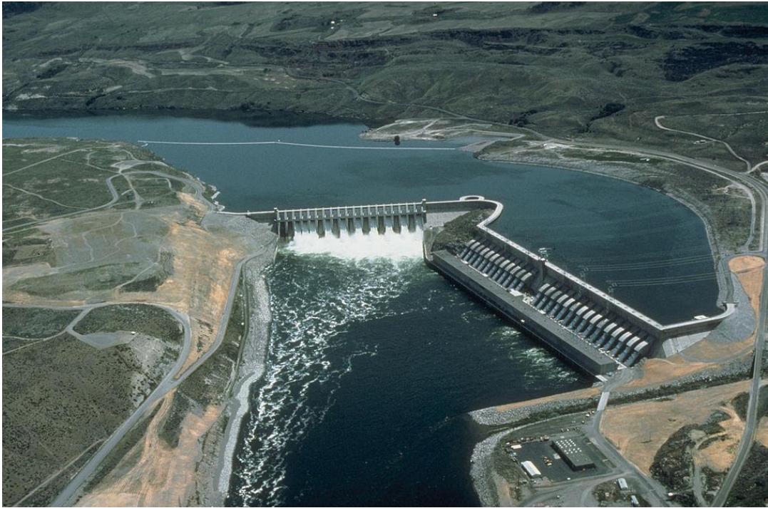
Slika 2.2. Protočna hidroelektrana [29]
