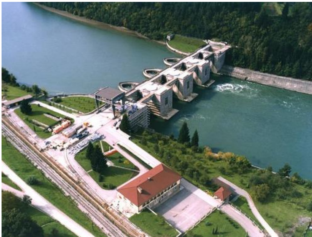
Slika 2.5. Hidroelektrana Vuzenica (agregati su u stupovima brane) [3]
