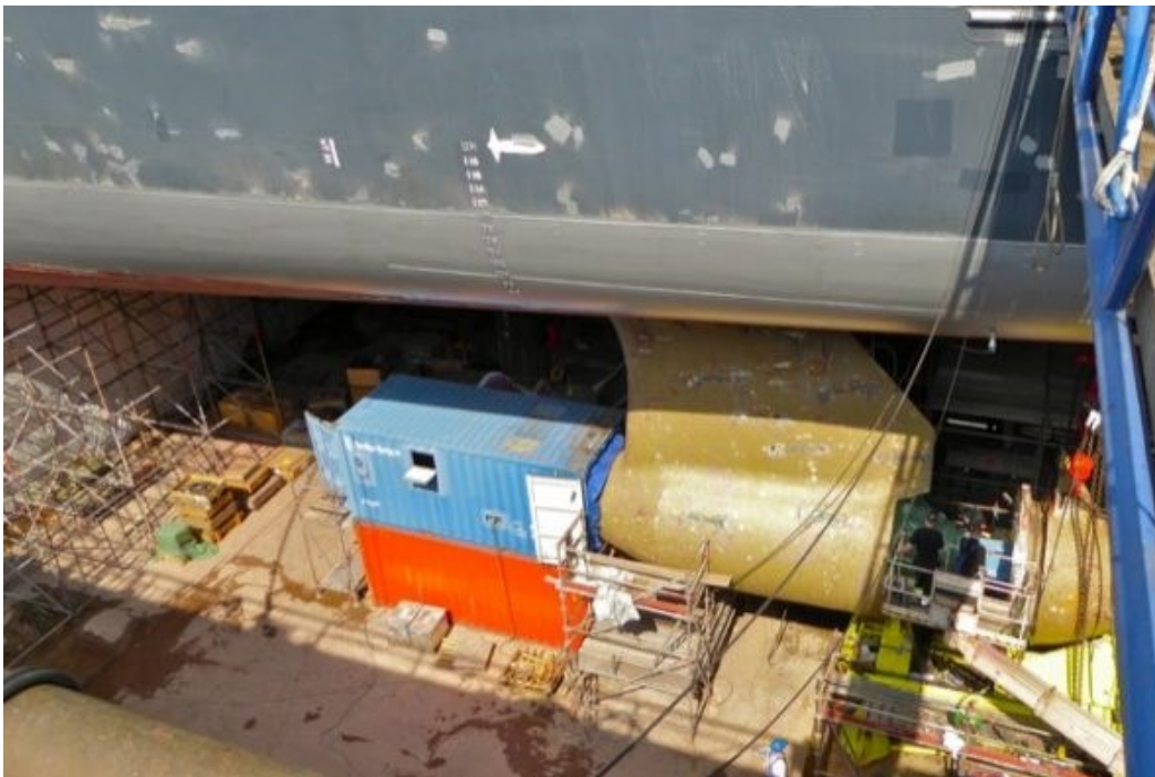
Slika 5.5.2. Rekonstrukcija FPP propelera firme Rolls Royce
