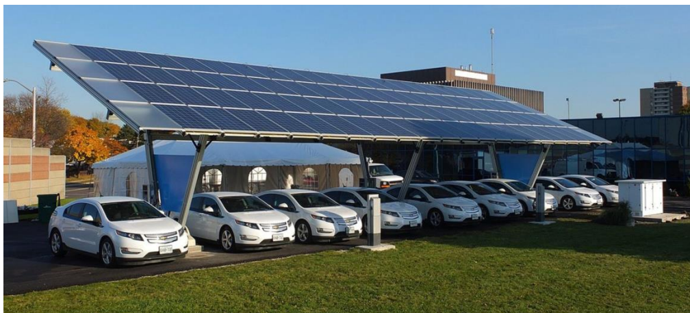
Slika 4.1 Solarna stanica za punjenje vozila na električni pogon [19]
