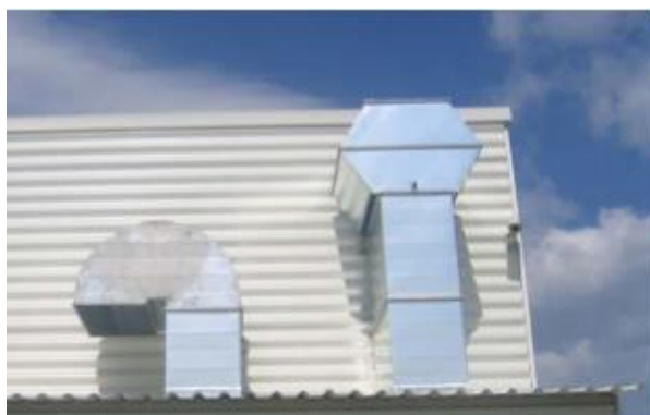
Sl. 2.7. Primjer prisilne ventilacije. [1]
