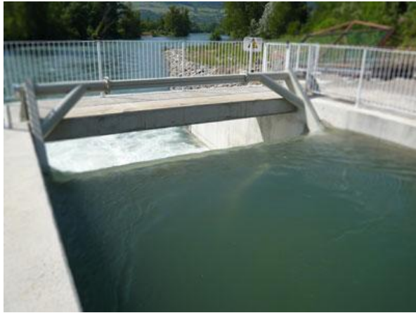
Slika 2.12. VLH turbina u radnom položaju
