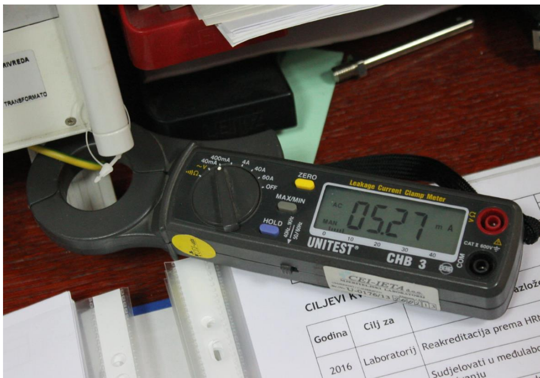
Sl. 3.16. Mjerenje struje odvoda tijekom ispitivanja izolacijskih rukavica
