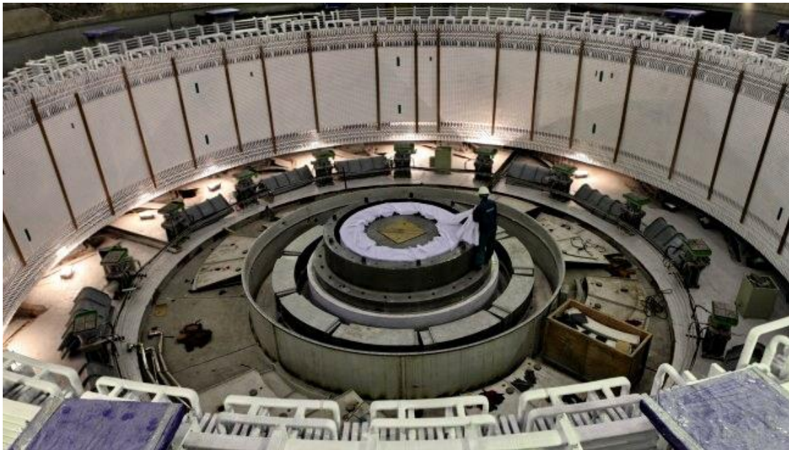
Slika 4.4. Sastavljanje statora u hidroelektrani, [26]
