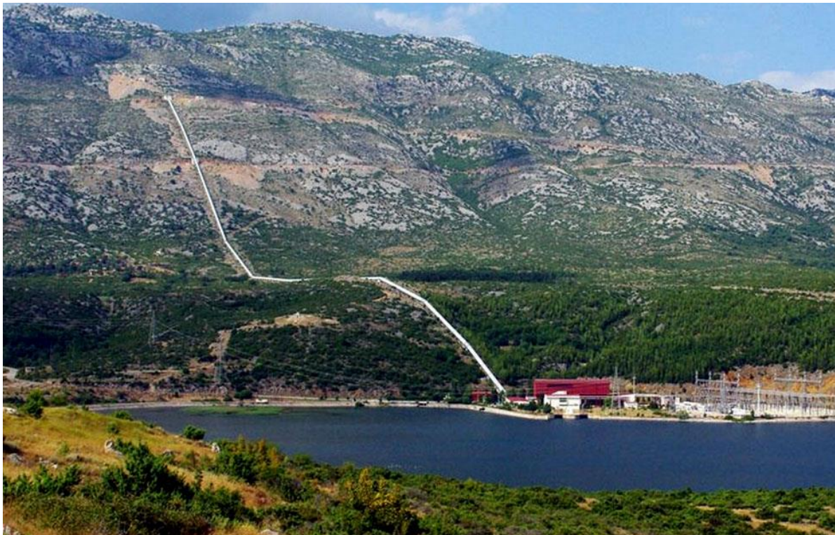
Slika 2.3. Reverzibilna hidroelektrana, [5]
