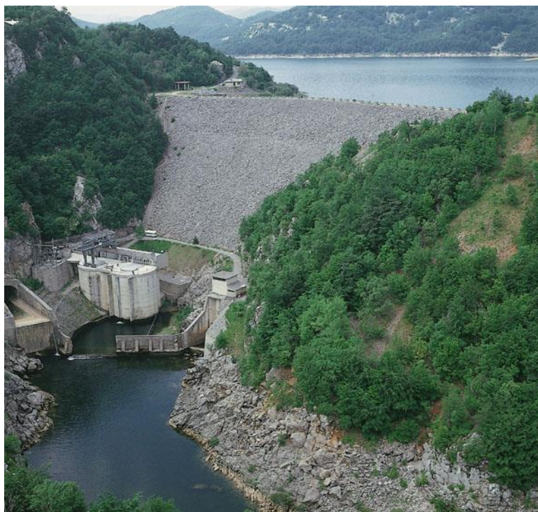
Slika 3.1 HE Sklope – Nasuta brana, [12]
