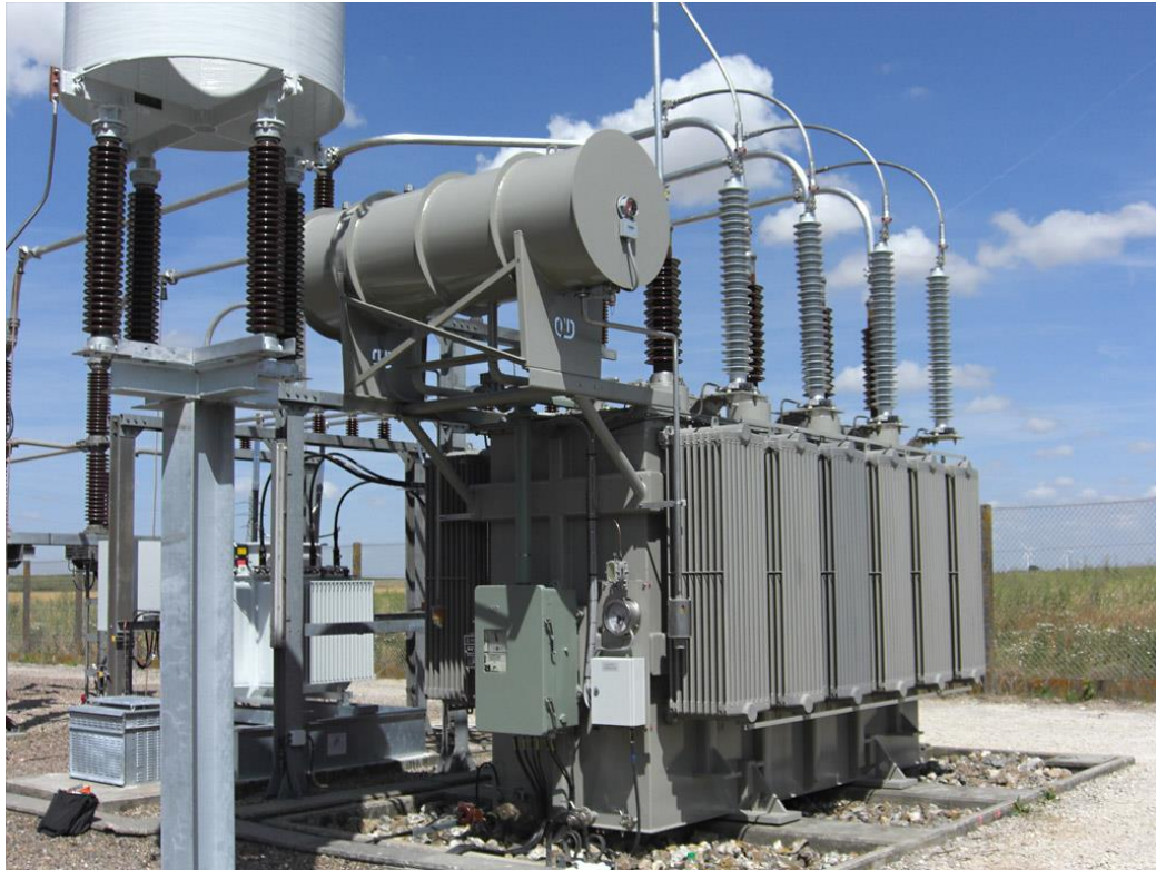
Slika 4.7. Energetski uljni transformator, [27]
