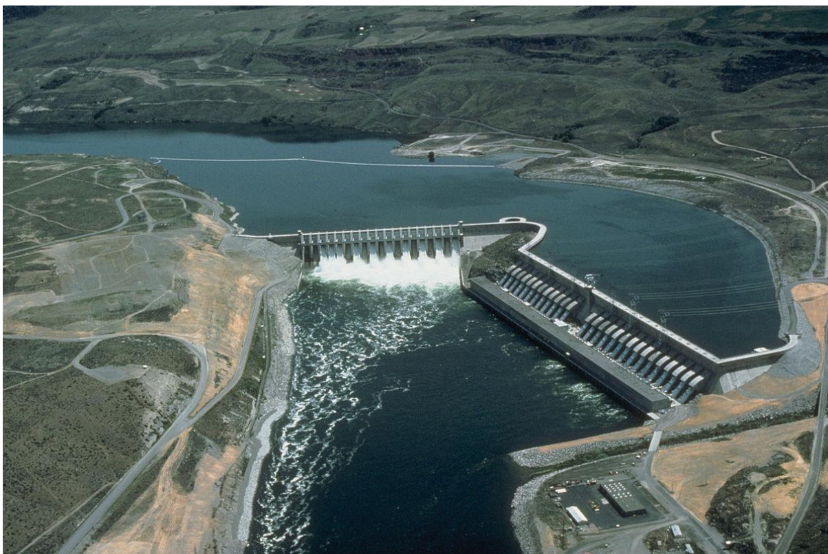
Slika 2.2. Protočna hidroelektrana, [4]
