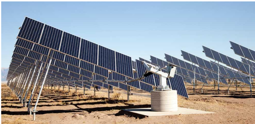
Slika 3.3. Primjer solarne farme s polarnim sustavom praćenja u Greater Sandhill, Mosca, SAD [10]
