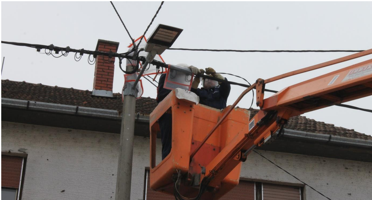
Slika 5.2. Spajanje novog kućnog priključnog ormarića na SKS
