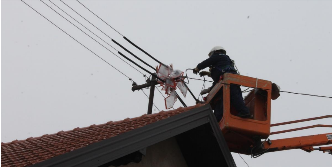
Slika 3.5. Operater u RPN izolira vodljive dijelove neizolirane gole mreže [5]
