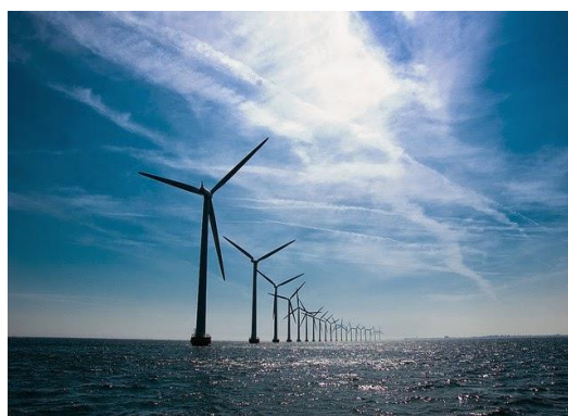
Slika 2.10. Vjetroelektrana u blizini Kopenhagena [6]
