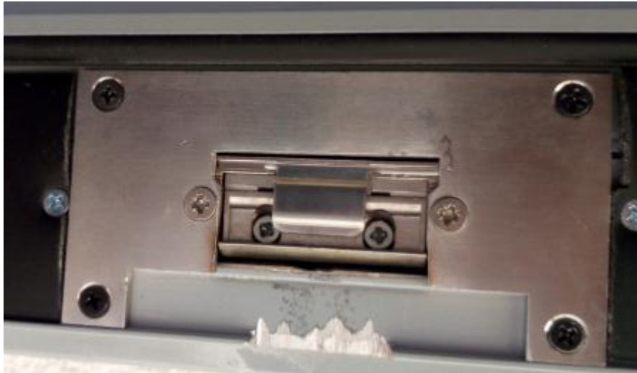
Sl. 5.2. Evakuacijski elektro prihvatač sa kontaktom vrata.
