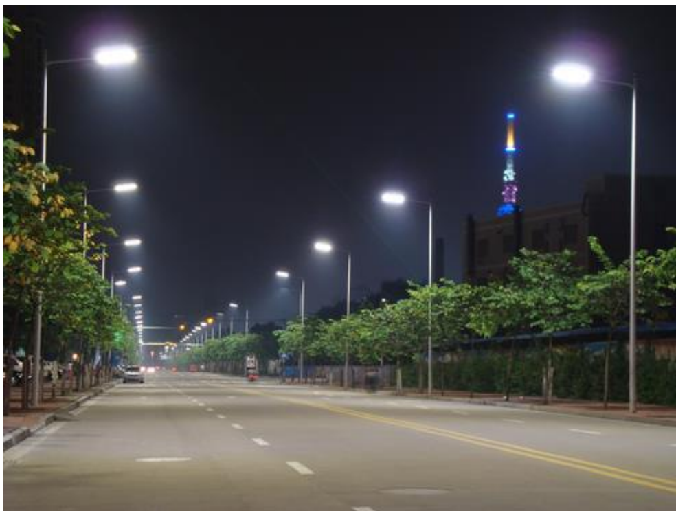
Slika(2.7.) Prometnica sa led rasvjetom[5]
