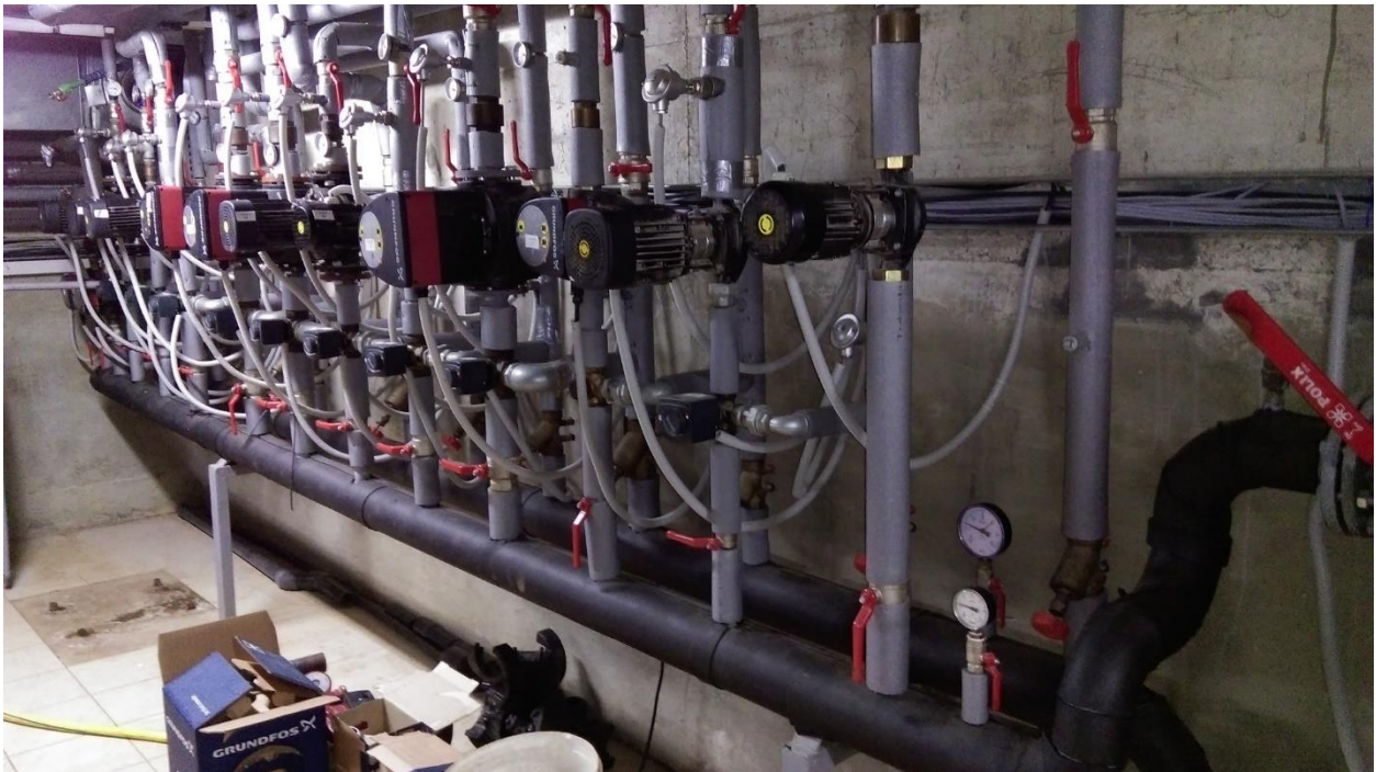
Slika 2.1. Krugovi grijanja u kotlovnici
