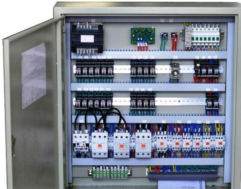
Slika 4.47. Relejna upravljačka jedinica [12]
