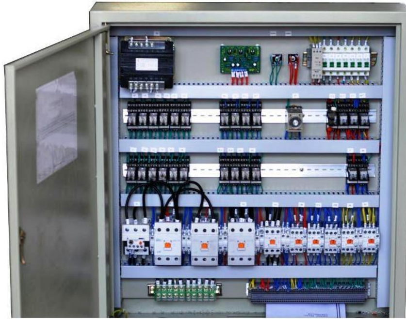
Slika 4.47. Relejna upravljačka jedinica [12]
