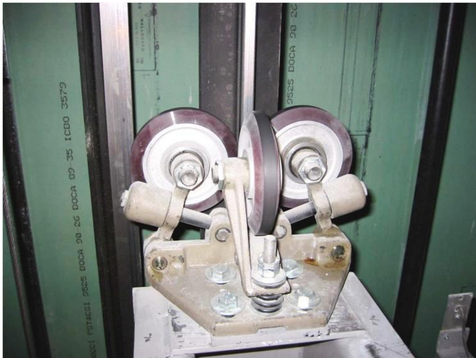
Slika 4.19. Valjkasto vođenje [10]
