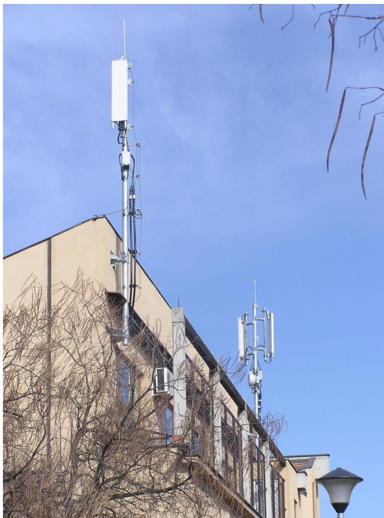
Sl. 3.2. Zgrada sa dvije montažne bazne postaje [11].
