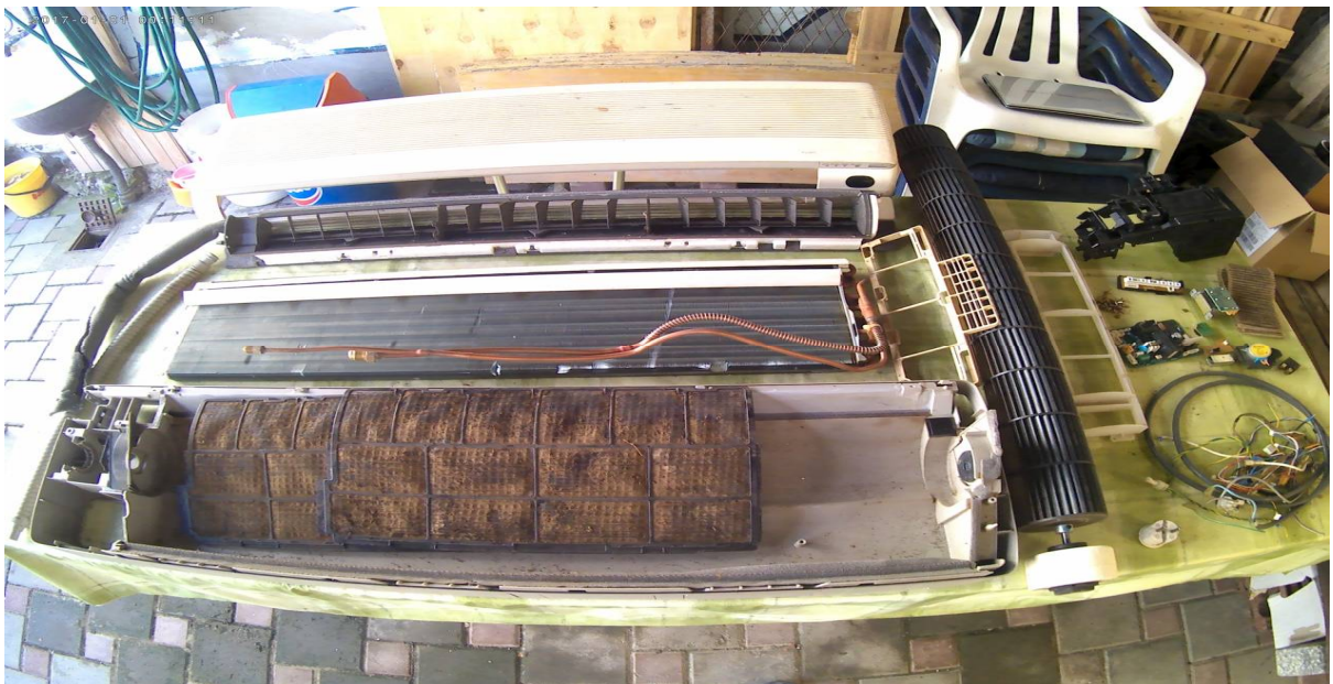
Slika 4.3. Rastavljena unutarnja jedinica klima uređaja
