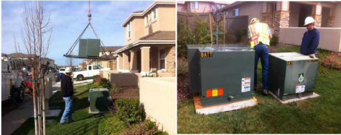
**Slika 6.1.** Jedinica za pohranu električne energije [4]
