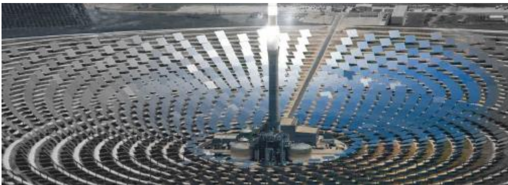
Sl.3.1. Solarna termoelektrana s centralnim tornjem i poljem heliostata [14].
