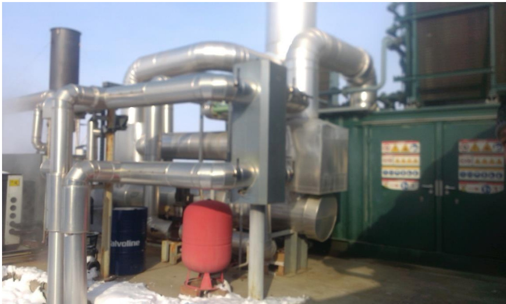
Slika 5.18. Baklja za spaljivanje plina
