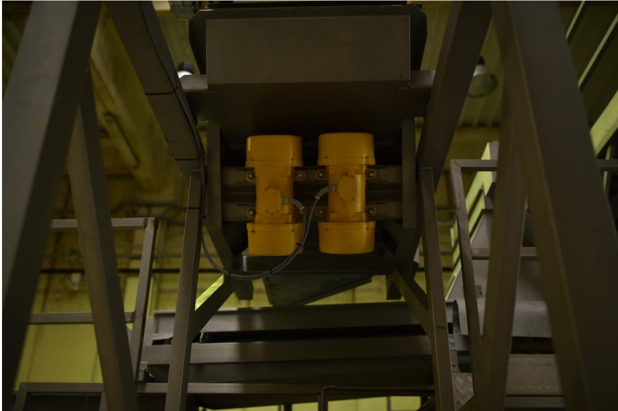
Slika 3.18. Dva Friedrich Schwingtechnik vibracijska motora postavljena u pogonu [1]
