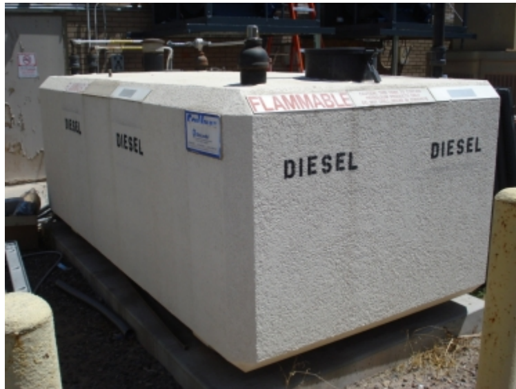
Slika 3.3. Sezonski spremnik goriva [5]
