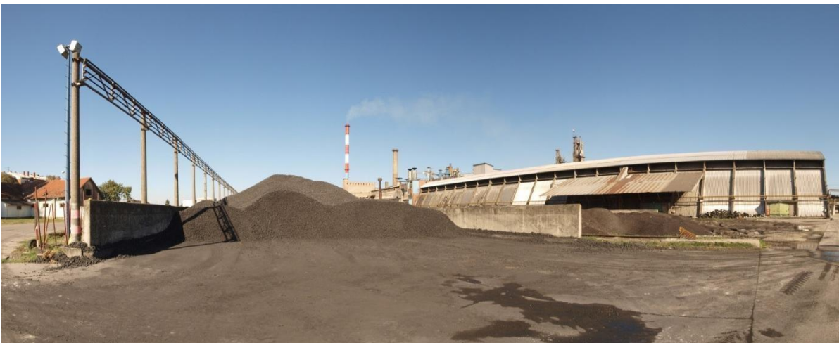
Slika 4.4. Pista za skladištenje koksa
