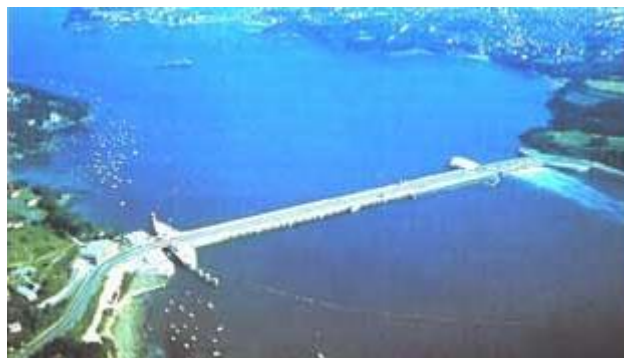
Slika 2.6. Elektrana plime i Oseke na ušću rijeke Rance u Francuskoj [22]
