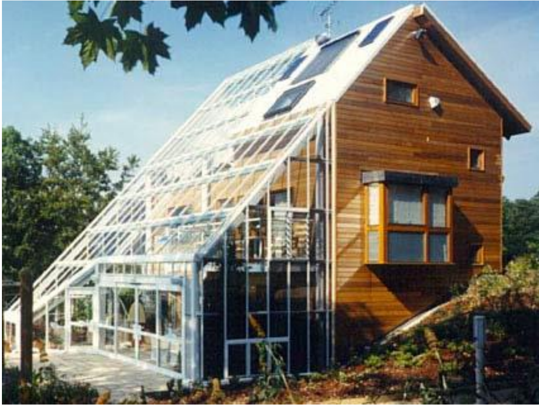
Slika 2.3. Primjer pasivnog iskorištavanja sunčeve energije [8]
