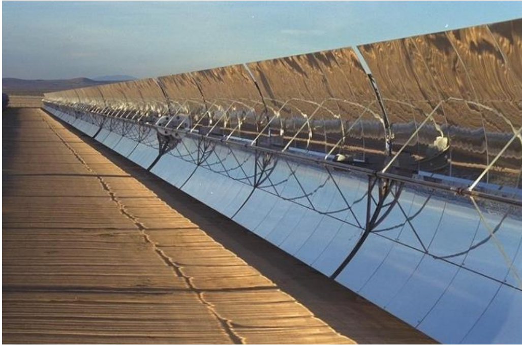
Slika 3.5. Parabolični kolektor solarne elektrane SEGS [16]
