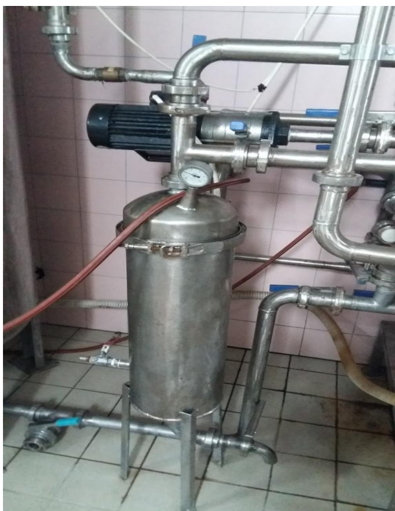
Slika 3.2. Filter za vodu
