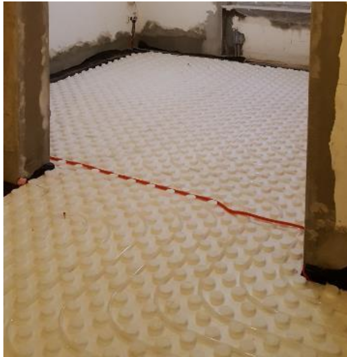
Slika 4.13. Postavljanje rastera za podno grijanje od ekspandiranog polistirena
