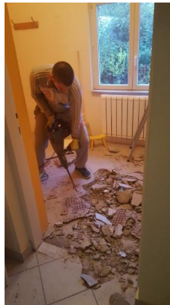
Slika 4.10. Uklanjanje postojećeg poda
