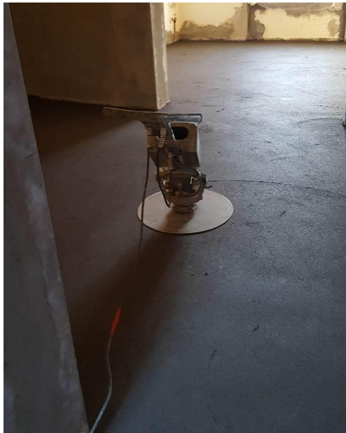
Slika 4.17. Vibrirajući stroj za nabijanje i zaglađivanje estriha
