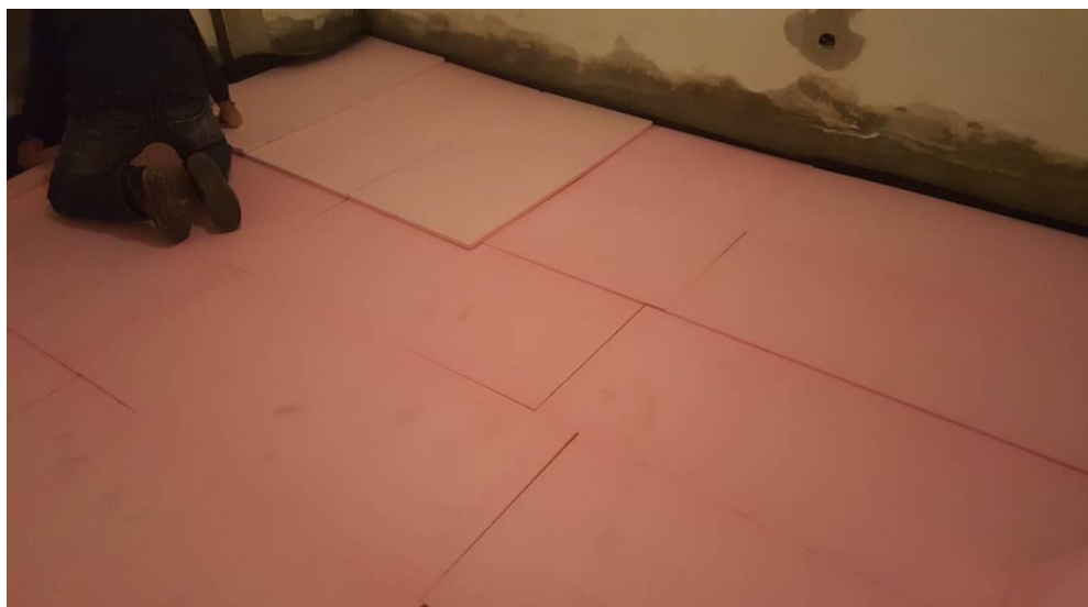
Slika 4.12. Postavljanje ekstrudirane polistirenske pjene
