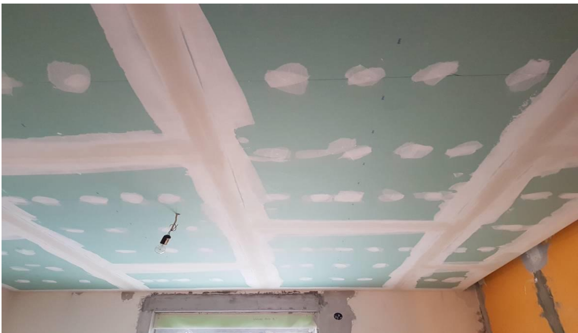
Slika 4.8. Postavljanje vodonepropusnih gipskartonskih ploča
