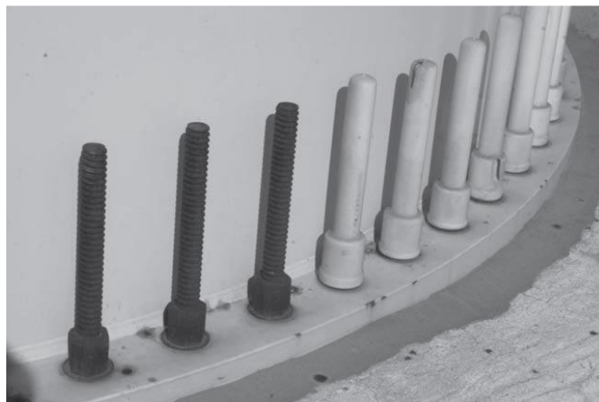
Slika 4.3: Vijci koji pričvršćuju stup za temelj. Preuzeto iz (Hemami, 2012).
