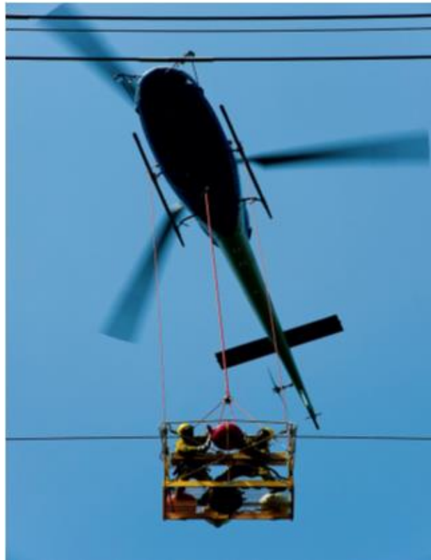
Sl. 3.3. Zamjena upozoravajućih kugli na prijenosnom vodu uz pomoć helikoptera [4].
