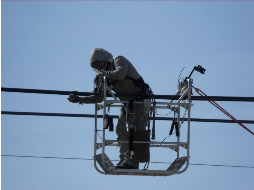
Sl. 6.2. Zamjena odstojnika na prijenosnoj mreži uz pomoć mobilne korpe [23].
