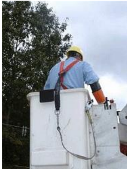
Sl. 5.6. Primjer sidrišta na korpi [20].
