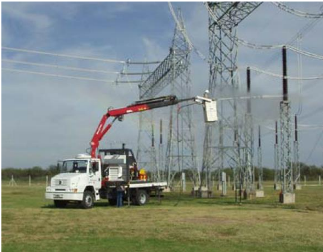
Sl. 3.12. Pranje izolatora s autoplatforme [5].
