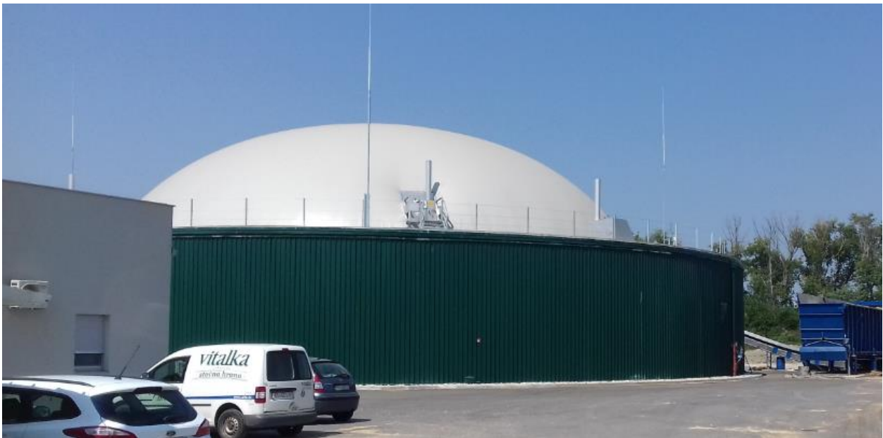
Slika 3.5. Digestor ili fermentor [fotografirano 23.8.2018. u Osijeku]
