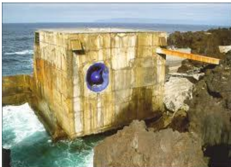
Sl. 3.8. 400 kW postrojenje na otoku Pico, Portugal [16]
