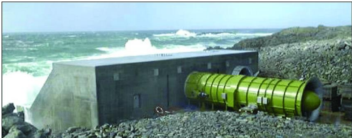
Sl. 3.9. 500 kW postrojenje LIMPET, otok Islay, Škotska [17]
