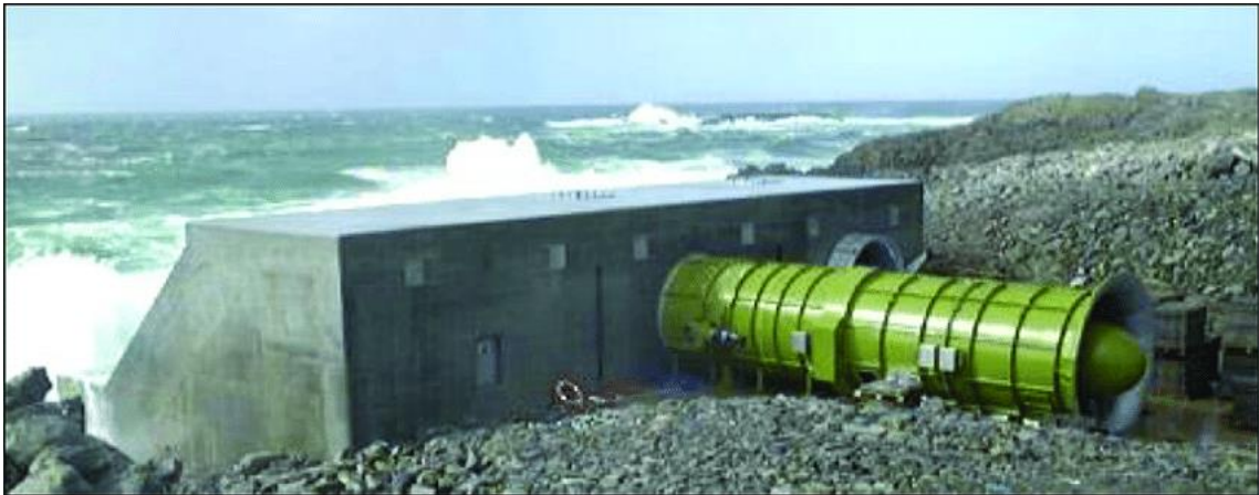
Sl. 3.9. 500 kW postrojenje LIMPET, otok Islay, Škotska [17]
