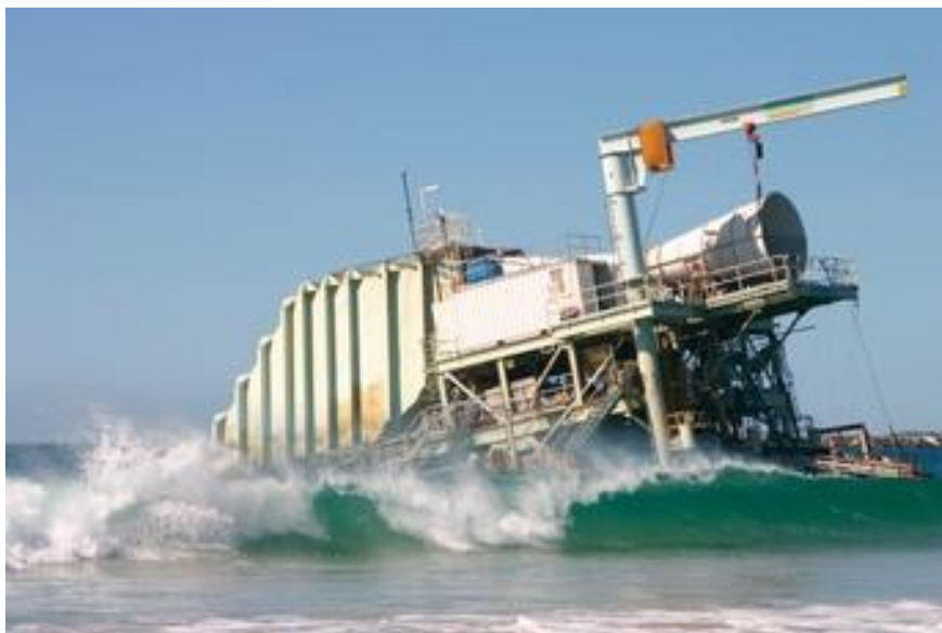
Sl. 3.11. 500 kW postrojenje, Australija [19]
