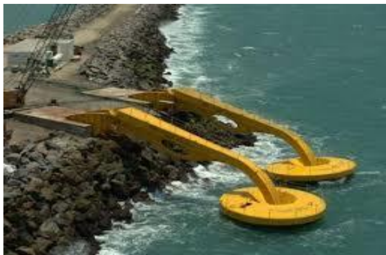
Sl. 3.32. Dvodijelni prototip hiperbaričnog uređaja instaliranog u lukobran, Brazil
