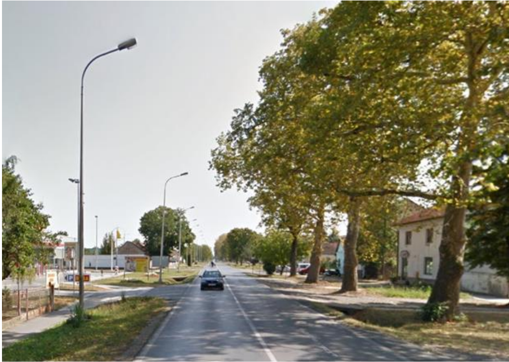
Slika 3.6 Postojeće svjetiljke Osječka ulica
