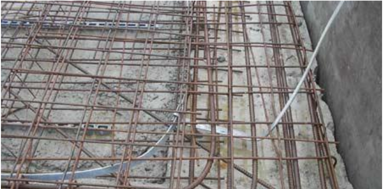
Slika 2.13 Temeljni uzemljivač[7]
