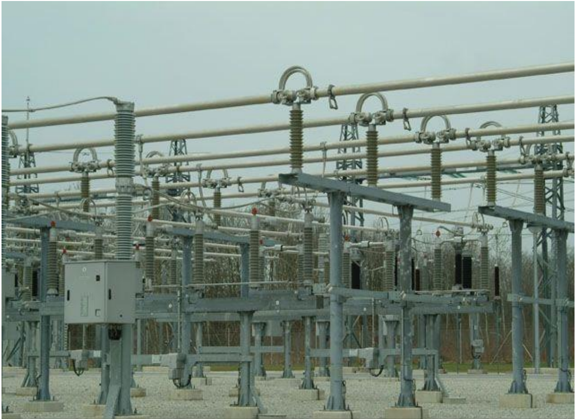
Slika 3.11. Diskontinuirane cijevi sabirničkog sustava [6]
