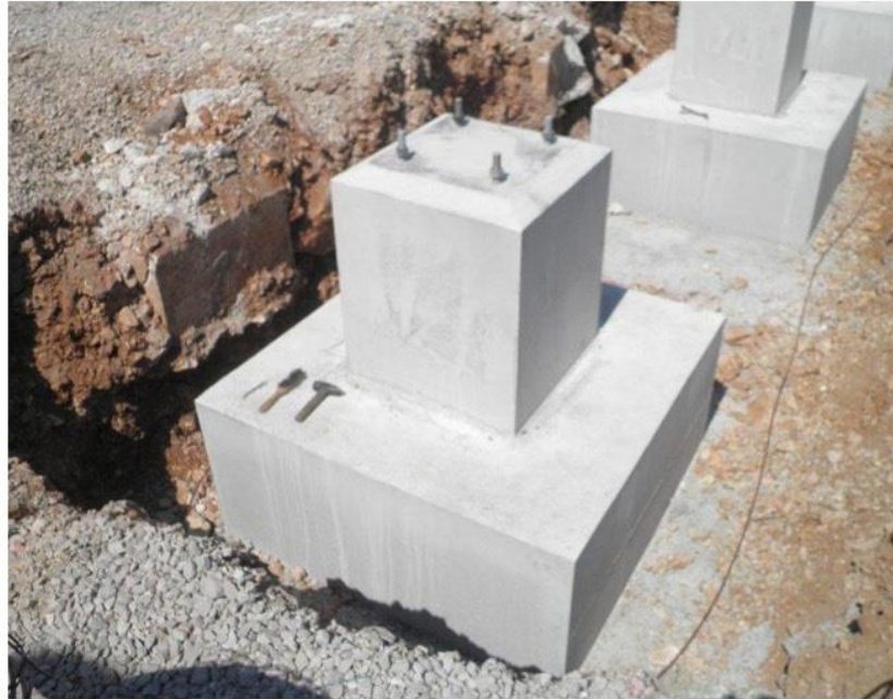
3.12. Izgradnja temelja u TS Bilice [8]
